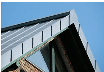
Вентилируемый конек двускатной крыши, высокое исполнение
