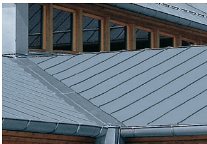
Ендова с простым и дополнительным фальцем
