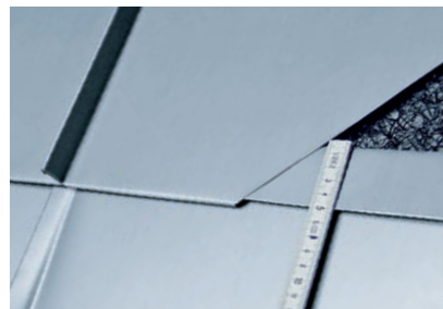
Поперечный шов, как простой фальц
