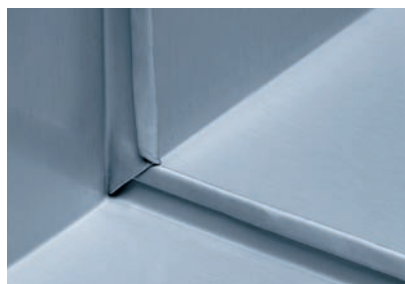
Фальц конвертом у проема кровли (2) фронтальная часть
