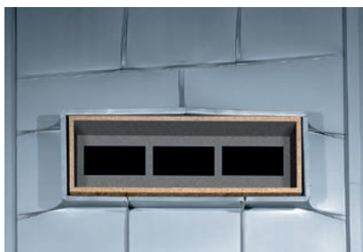
Проем в крыше Правильное исполнение в фальцевой технике (см.стр. 12)
