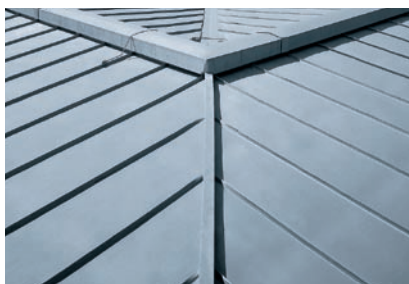
Гребень с брусом и профилем покрытия
