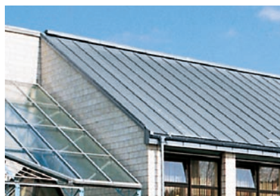
Конек односкатной кровли с брусом кровли
