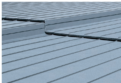
Поперечный шов в качестве перепада
