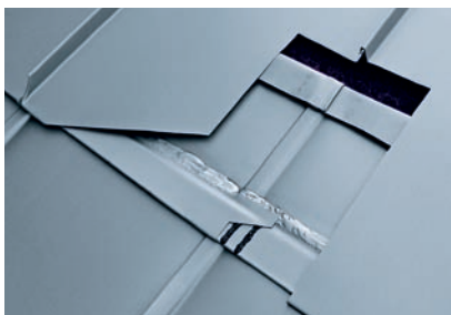
Оптимизация узла: дополнительная планка
