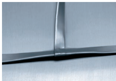
Узел соединения (4) Картины к поперечному фальцу тыловая часть
